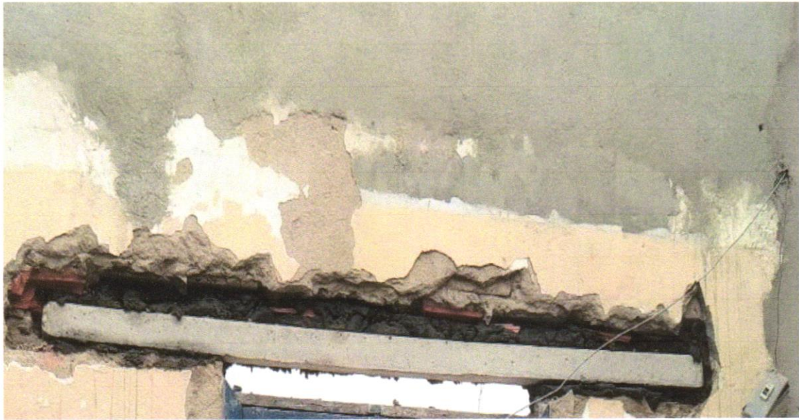
Foto 05- CONTRAVERGA PRÉ-MOLDADA PARA VÃOS DE ATÉ 1,5 M DE COMPRIMENTO. AF_03/2016
