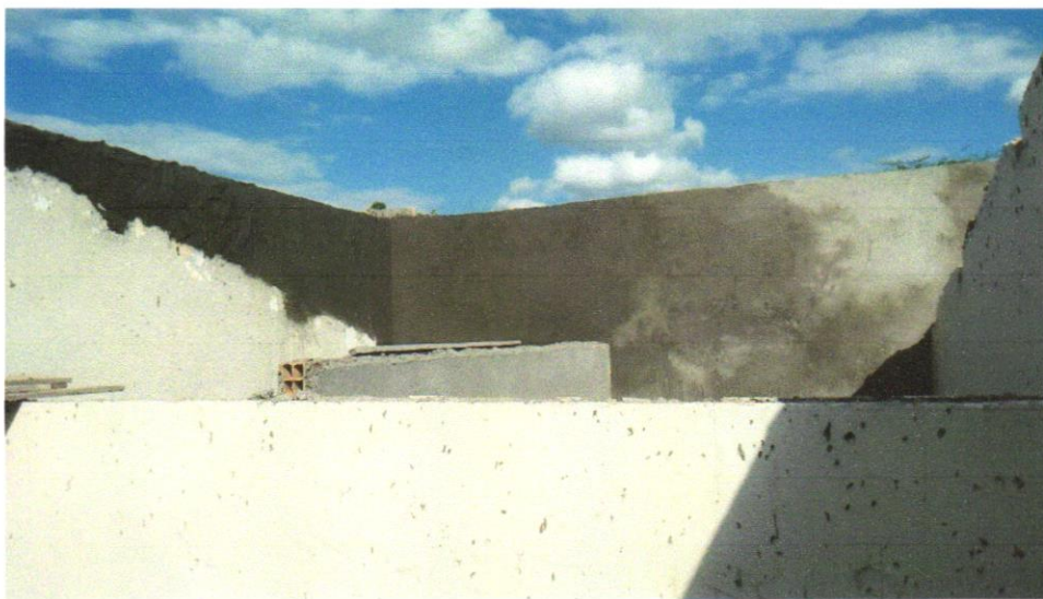
Foto 07 - MASSA ÚNICA, PARA RECEBIMENTO DE PINTURA OU CERÂMICA, ARGAMASSA INDUSTRIALIZADA, PREPARO MECÂNICO, APLICADO COM EQUIPAMENTO DE MISTURA E PROJEÇÃO DE 1,5 M3/H EM FACES INTERNAS DE PAREDES, ESPESSURA DE 5MM, SEM EXECUÇÃO DE TALISCAS. AF_06/2014
