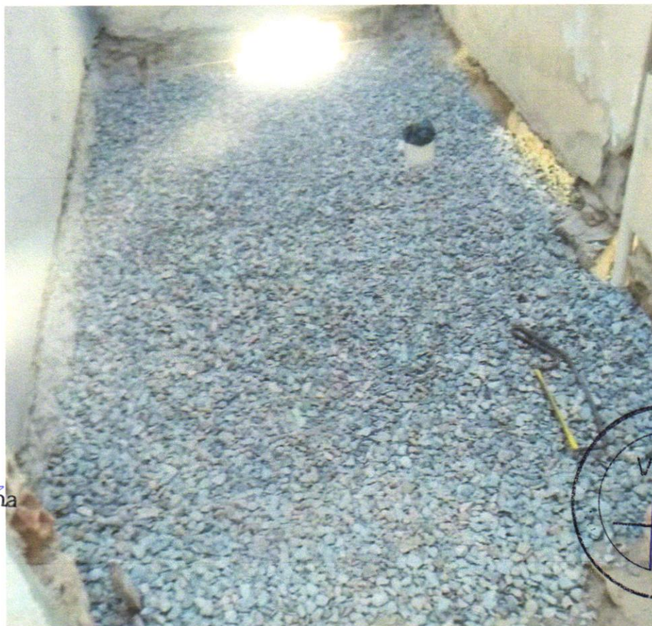
Foto 08 - Lastro de brita graduada apiloada e=10cm
