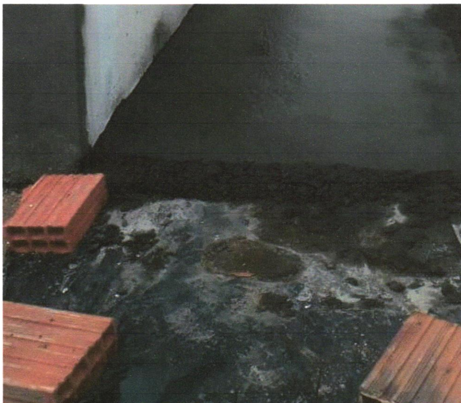
Foto 09 - APLICAÇÃO DE LONA PLÁSTICA PARA EXECUÇÃO DE PAVIMENTOS DE CONCRETO. AF_04/2022
