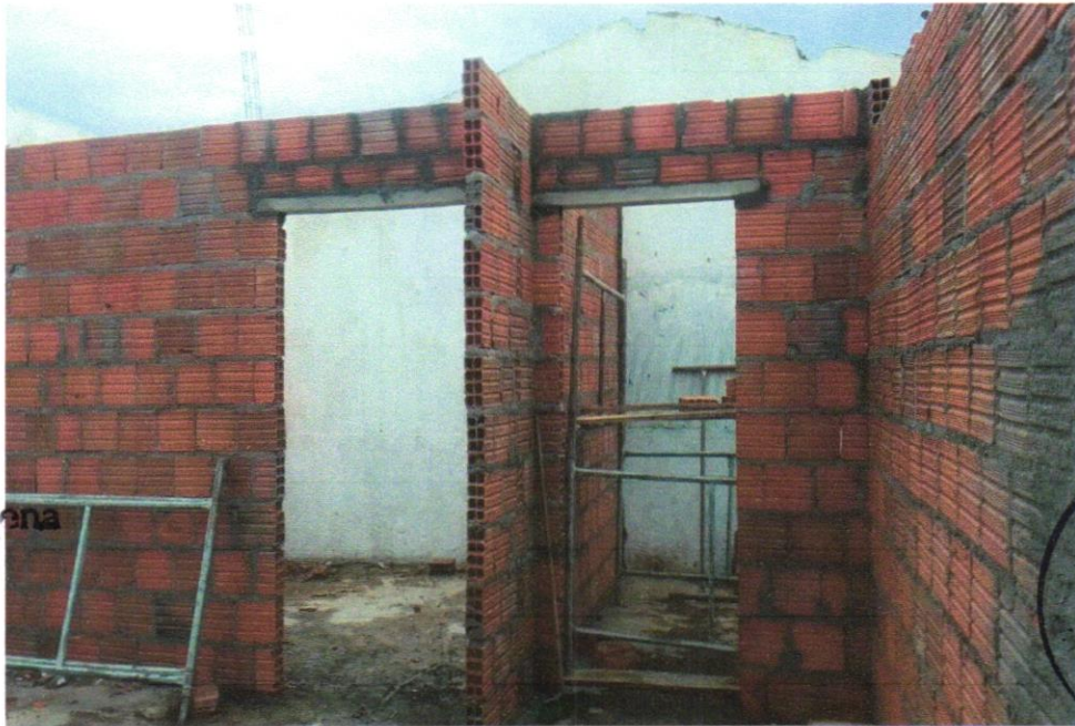
Foto 14- ALVENARIA DE VEDAÇÃO DE BLOCOS CERÂMICOS FURADOS NA HORIZONTAL DE 9X19X29 CM (ESPESSURA 9 CM) E ARGAMASSA DE ASSENTAMENTO COM PREPARO EM BETONEIRA. AF_12/2021
