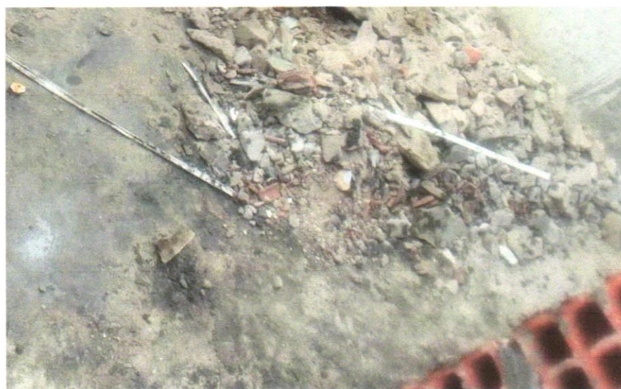
FOTO 01 – Demolição de reboco
