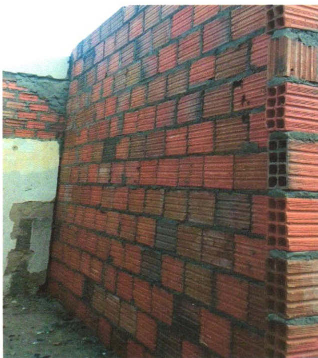
Foto 03 - ALVENARIA DE VEDAÇÃO DE BLOCOS CERÂMICOS FURADOS NA HORIZONTAL DE 9X19X29 CM (ESPESSURA 9 CM) E ARGAMASSA DE ASSENTAMENTO COM PREPARO EM BETONEIRA. AF_12/2021
