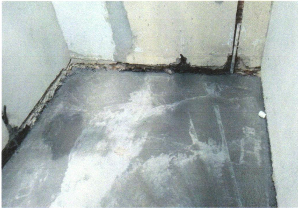
Foto 13 - PISO EM CONCRETO 20 MPA PREPARO MECÂNICO, ESPESSURA 7CM. AF_09/2020
