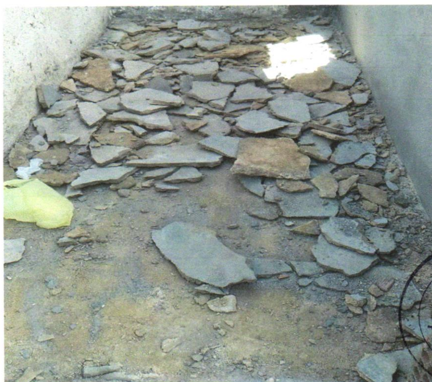
FOTO 02 – Demolição manual de piso cimentado sobre lastro de concreto - Rev 01
