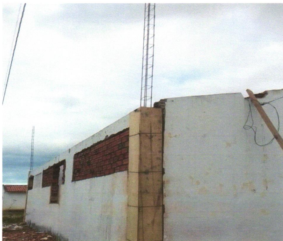
Foto 11 - (COMPOSIÇÃO REPRESENTATIVA) EXECUÇÃO DE ESTRUTURAS DE CONCRETO ARMADO, PARA EDIFICAÇÃO HABITACIONAL UNIFAMILIAR TÉRREA (CASA EM EMPREENDIMENTOS), FCK = 25 MPA. AF_01/2017
